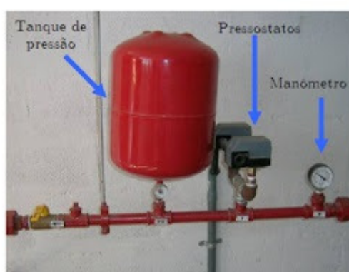
Exemplo de conjuntos montados em obra. Os elementos devem ser certificados UL/FM
